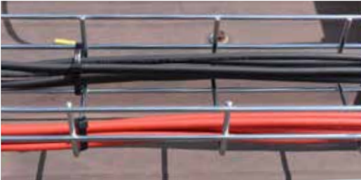
Cuando se separan dos veces el diámetro de envolvente los grupos de cable, no es necesario considerar agrupamiento entre los mismos (en tendidos horizontales). Imagen cortesía de SPV Sistemas.
