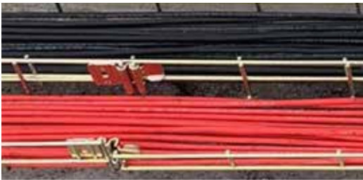
Cuando se separan dos veces el diámetro de envolvente los grupos de cable, no es necesario considerar agrupamiento entre los mismos (en tendidos horizontales). Imagen cortesía de SPV Sistemas.
